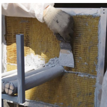
▶ Процесс монтажа конструкции ОГРАКС-КП
